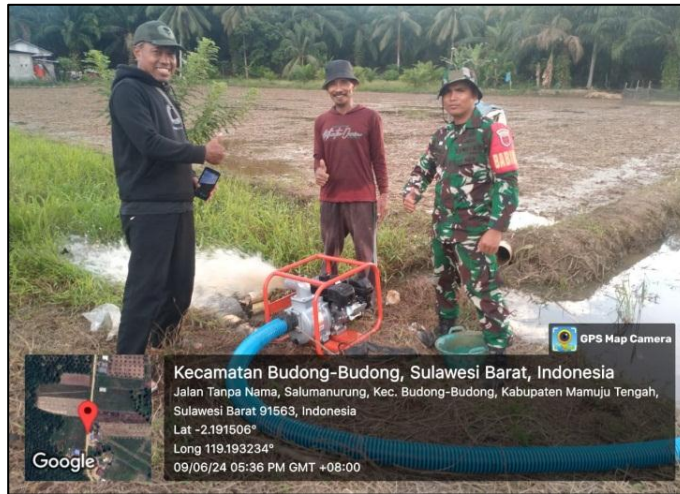
Gambar 24. Pemasangan pompa di kecamatan Budong-budong
